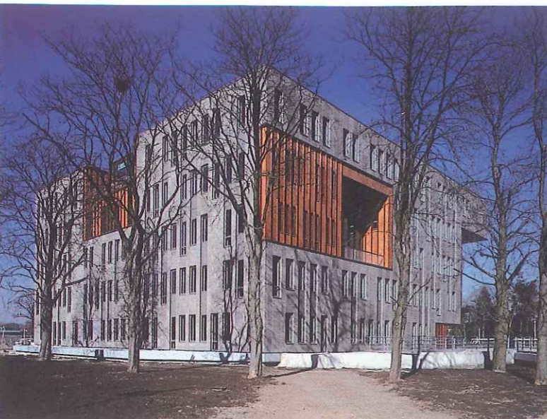
[De U-vormige verdiepingen zijn telkens een kwartslag gedraaid ten opzichte van de daaronder gelegen bebouwing.]
