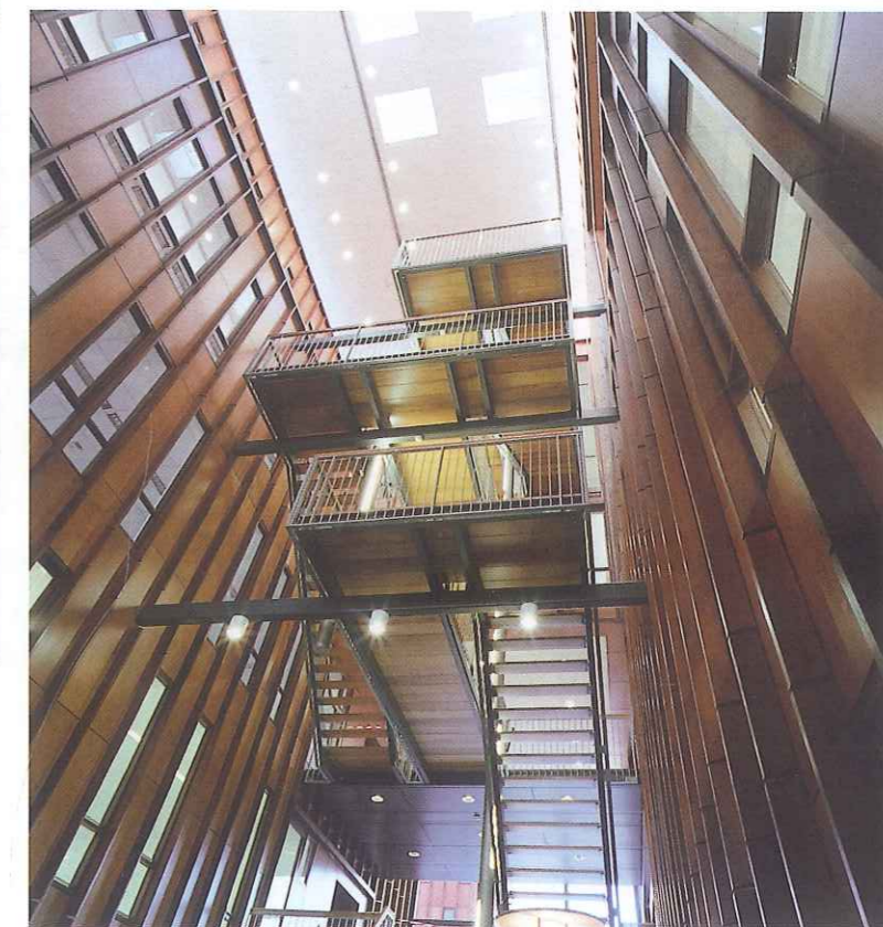
[Merantihouten platen kleden ook het interieur af. De traptreden en vloeren van de loopbruggen zijn van iroko.]
