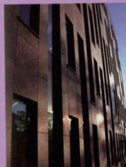
In de natuurstenen gevels zijn de aluminium kozijnen weggedetailleerd achter de gevelpanelen. Zie detail 2
