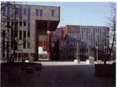
Kantorencomplex gezien vanaf de westzijde.
