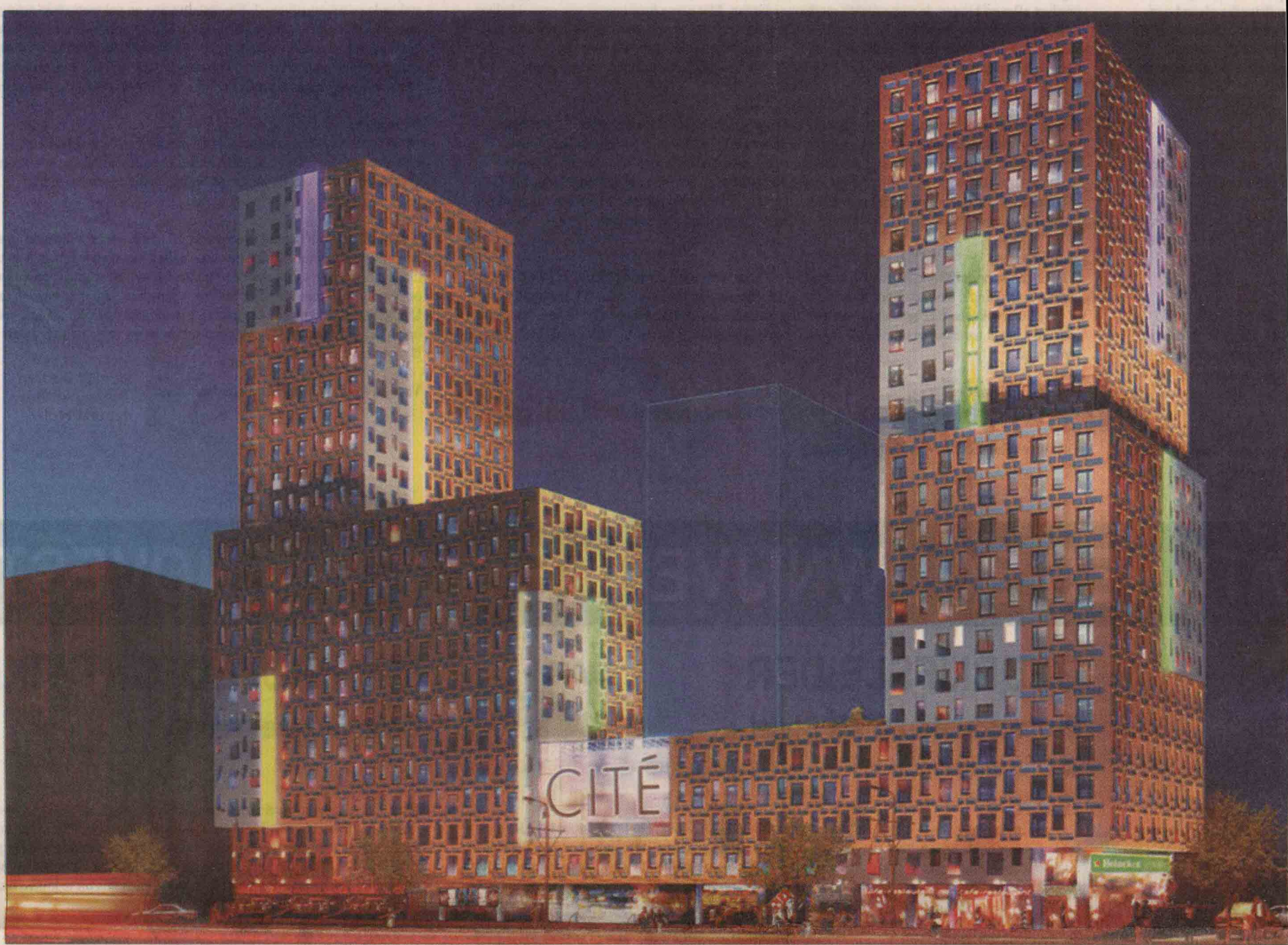
Het complex bestaat uit twee torens, waarvan de hoogste 84 meter is en een middenstuk dat aansluit op de uitbreiding van InHolland.
