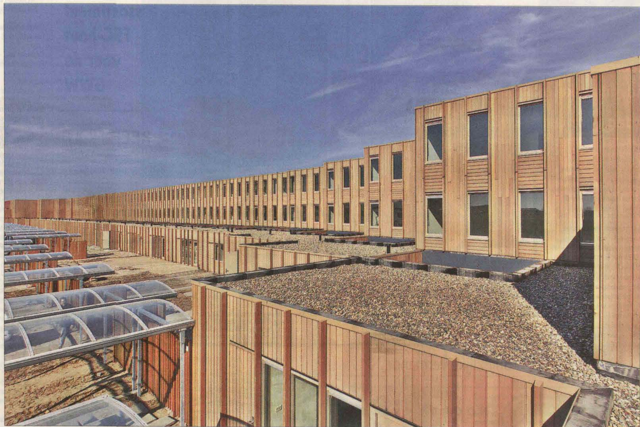
De voorzijde van de geluidswoningen aan de Hagevoortdreef in Almere. De vierkante 'gaten' in de daken zijn de patio's.
