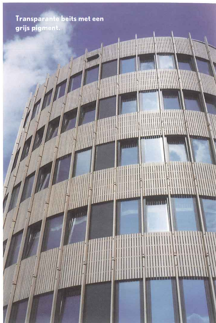
De gevelbekleding valt in de Europese brandklasse B.
