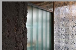
texturen robuust beton, matglazen stroken, opengewerkt glasvlies
