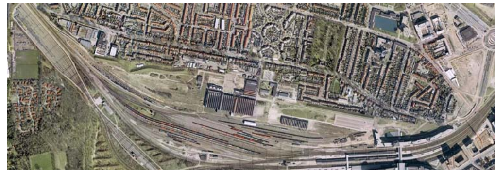
Situatie oud: voormalige onderhoudswerkplaats Nederlandse Spoorwegen, gesloten in 2000
